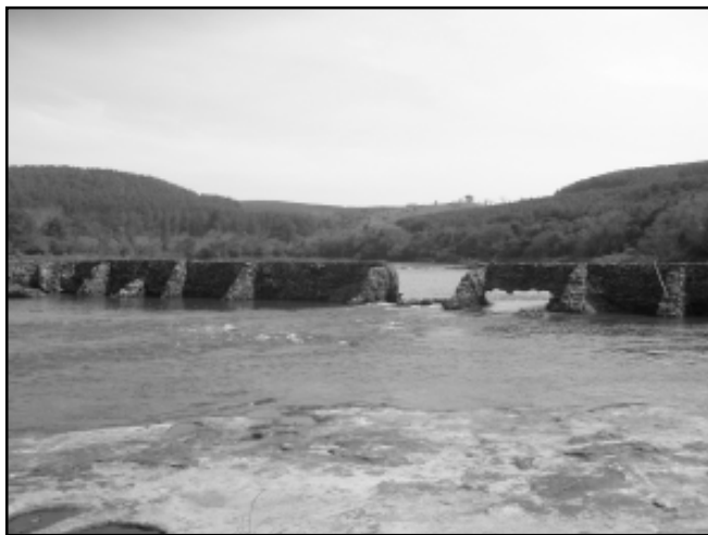
Foto 13. Remanescentes dos diques de barragem no rio Tibagi.
