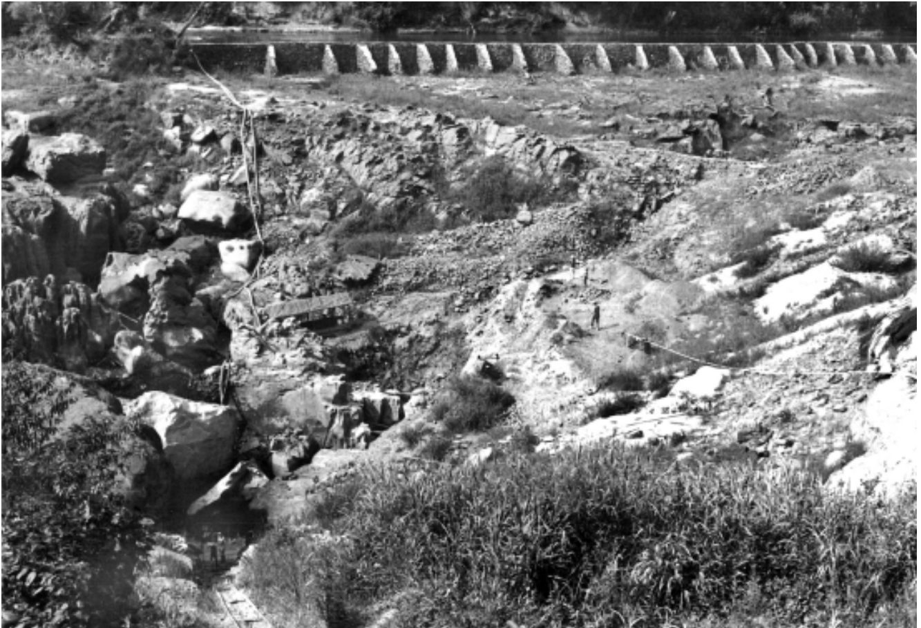
Figura 1. Imagem da lavra experimental instalada na localidade de Campina dos Pupos, mostrando a barragem construída para o desvio das águas na parte superior e a retirada do cascalho mineralizado por vagonetes na parte inferior. Foto: Dalton Mesquita – 1985.
