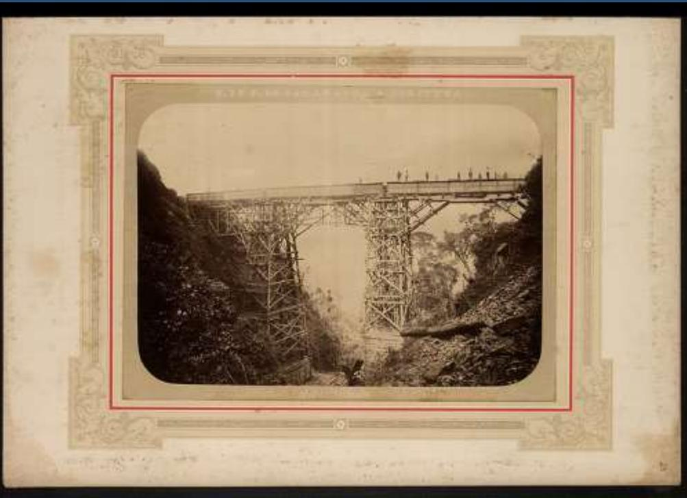
Possui 14 túneis escavados na rocha, 41 pontes e viadutos em dimensões colossais, utilizando estrutura metálica. O Viaduto Carvalho, construído com grande tenacidade, está a mais de 900m de altitude, usando como suporte muros de até 100m de altura fazendo uma curva de 45 graus no trecho conhecido como Curva do Diabo.
