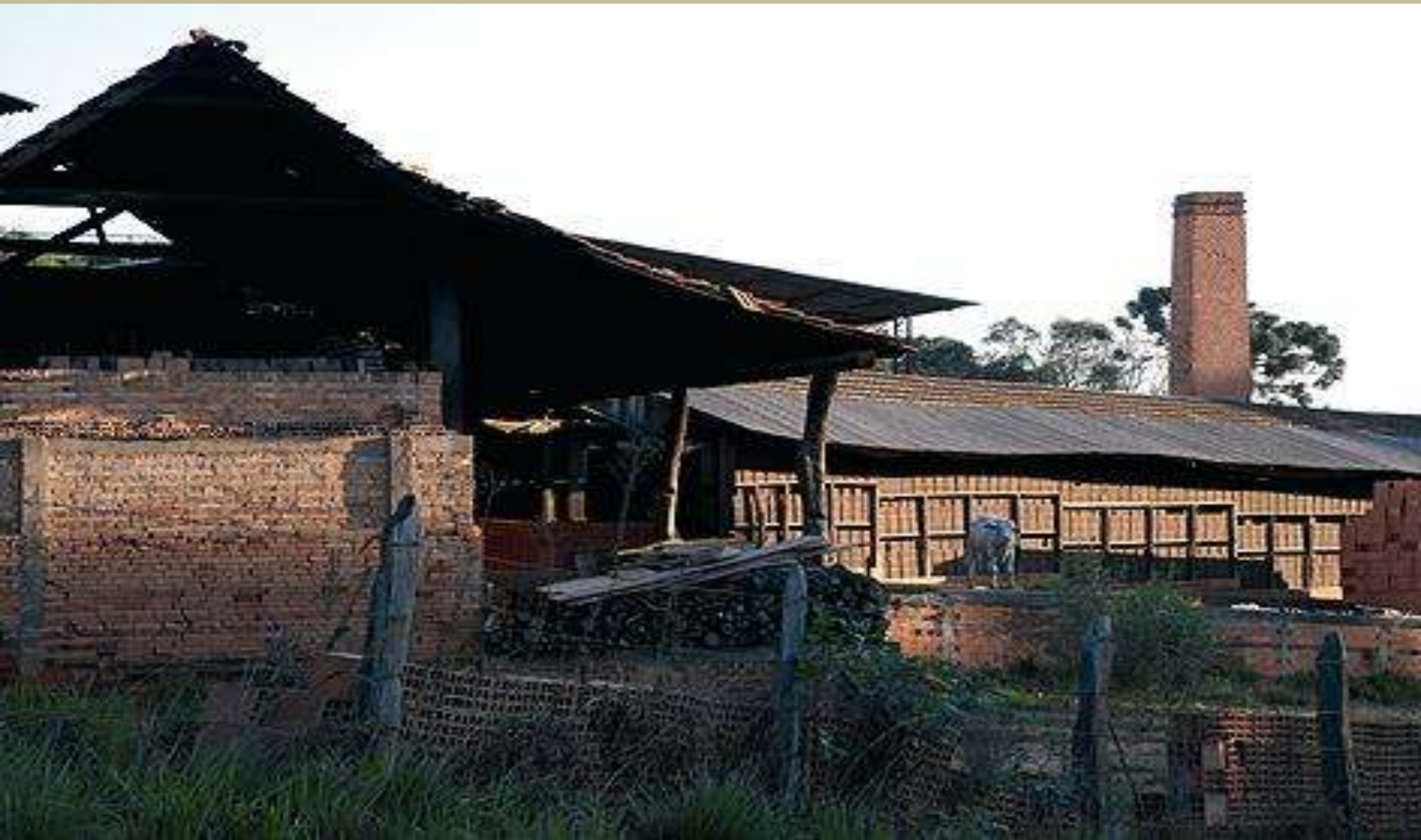
Olarias e cavas de areias instaladas nas planícies aluvionares de Curitiba
