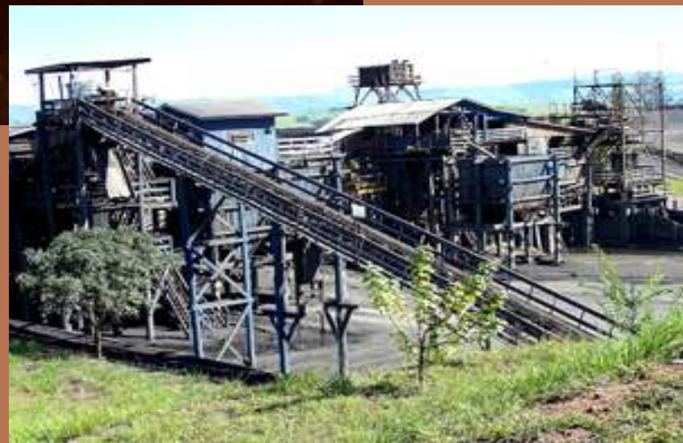
Mina de Cambuí - Figueira
