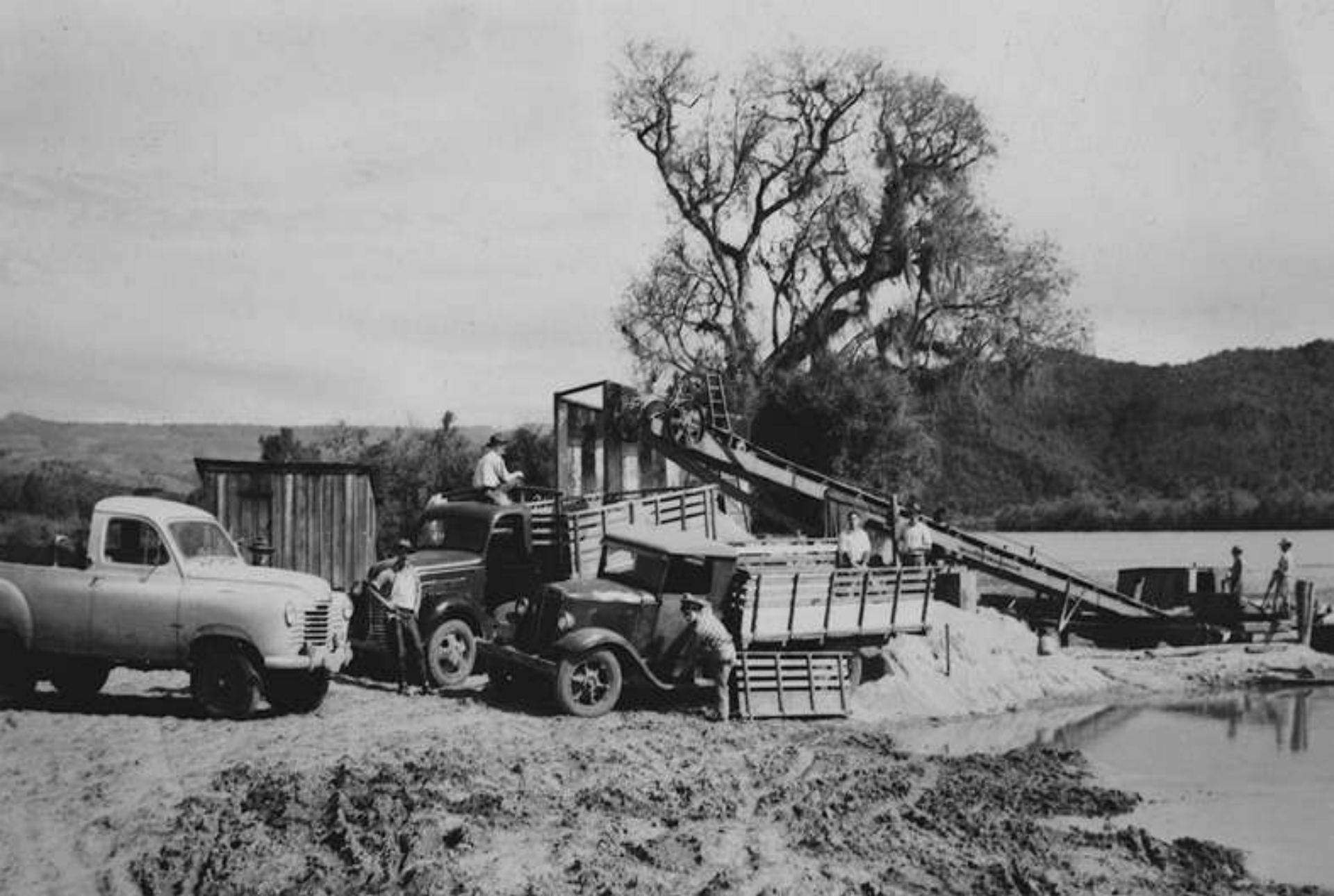
Extração de areia no Rio Iguaçu na década de 1940 – Hobi mineração – União da Vitória
